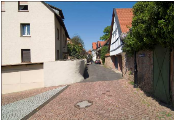
Am Steinbrunnen / Ecke Stephanusberg: Straßenpflasterung
