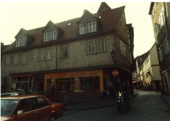
Untermarkt - 1984 bei Sanierungsbeginn
