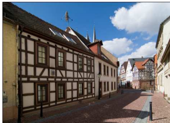
Modernisierung in der Oberen Haitzer Gasse
