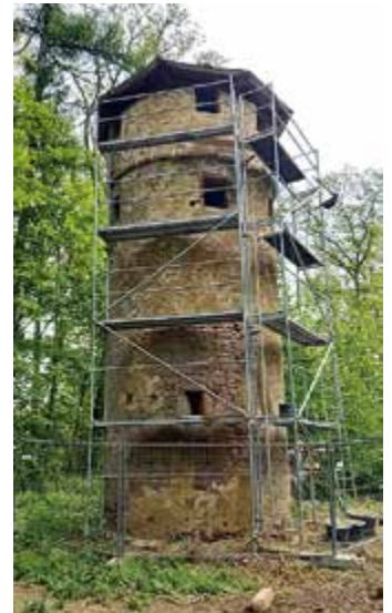
Ein Dach aus Fichtenholz bot dem Wartturm keinen ausreichenden Schutz vor der Witterung. Das Bauamt der Stadt kümmerte sich bei der Sanierung um eine fachmännische Abführung von Niederschlagswasser.
