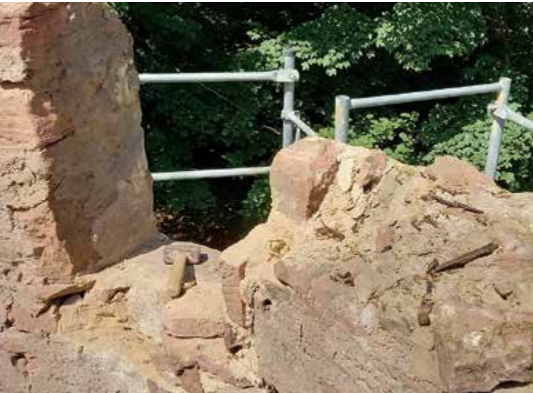
Eine der Turmzinnen war weggebrochen und wurde wiederaufgebaut.
