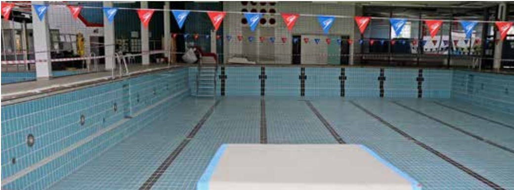
Das Hallenbad-Team hat die Sommerpause natürlich auch zur gründlichen Reinigung genutzt. Die Becken wurden abgelassen.
